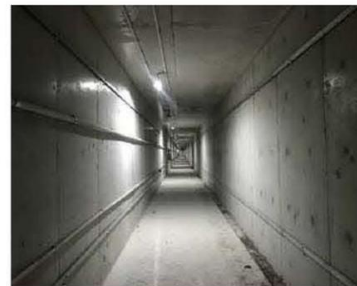
天津南站商务区综合管廊
