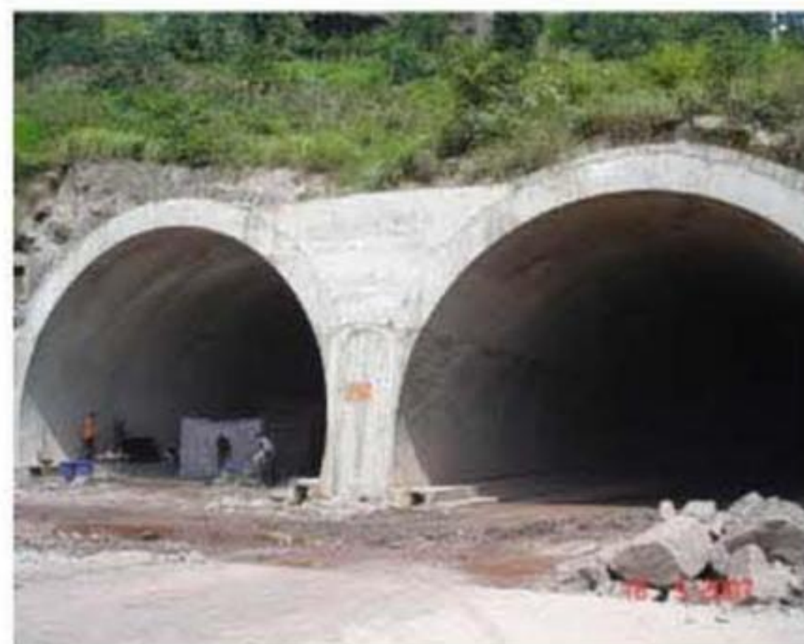
云南水麻高速双拱隧道
