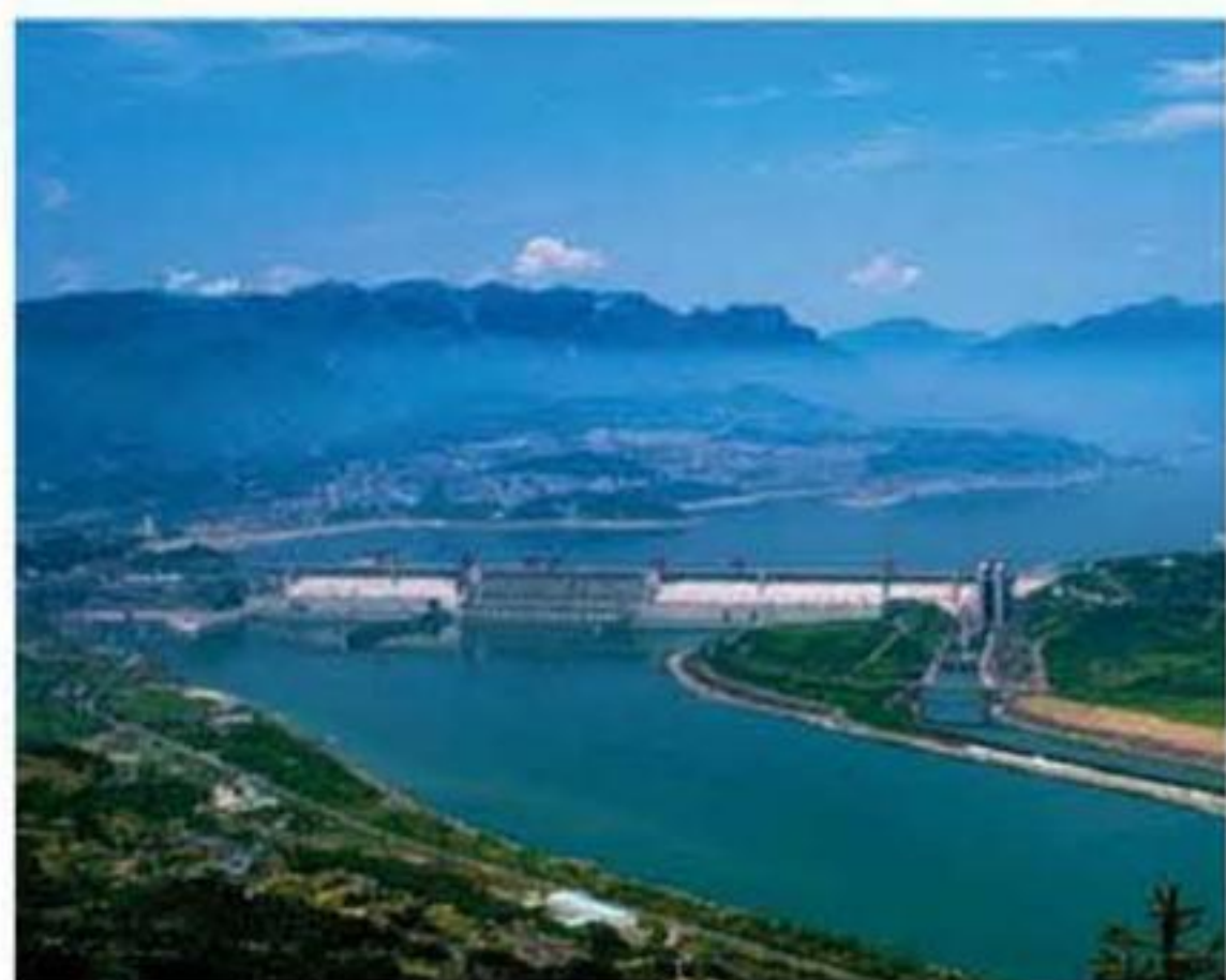
三峡大坝工程
